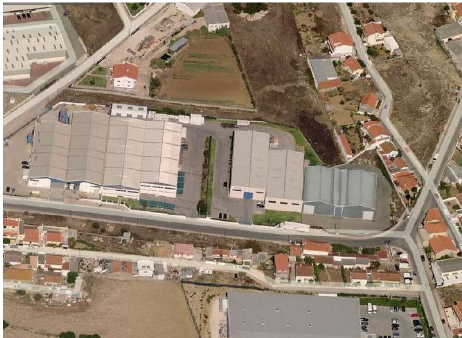
Figura 3.1- Instalações da Represtor.
